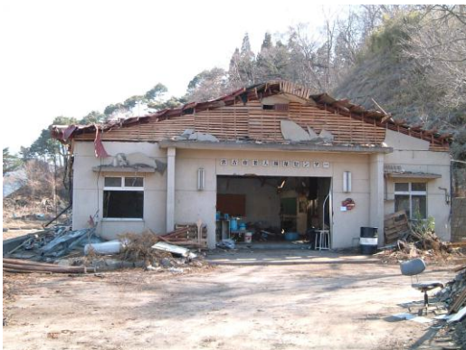
全壊した事務所・宮古市磯鶏老人センター
