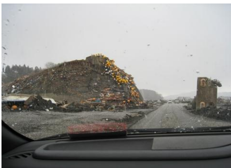
山田線：鉄橋の破損！
